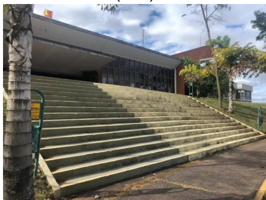
Figura 2: Escada de acesso do Bloco 1 (2020)
