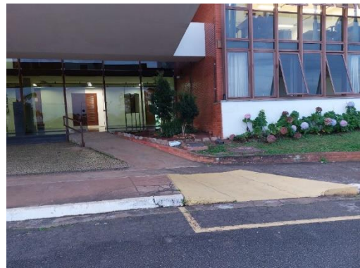
Figura 7: Rampa de acesso do Bloco 1 (2023)
