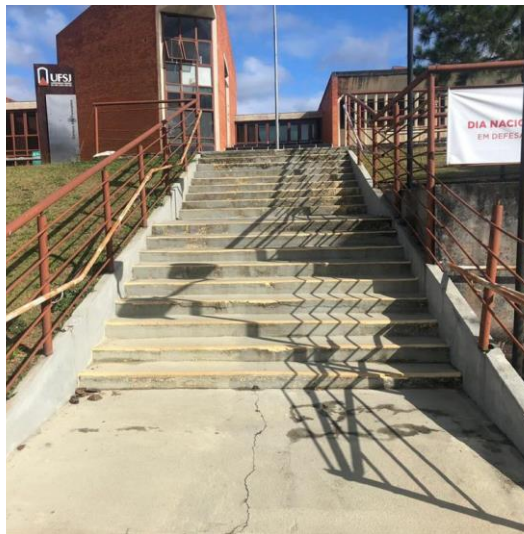
Figura 4: Escada de acesso do Bloco 5 (2020)
