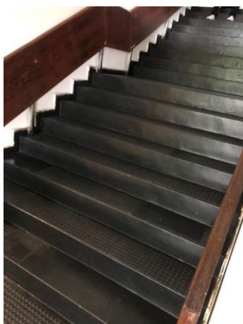
Figura 12: Escada de meio de bloco (2020)
