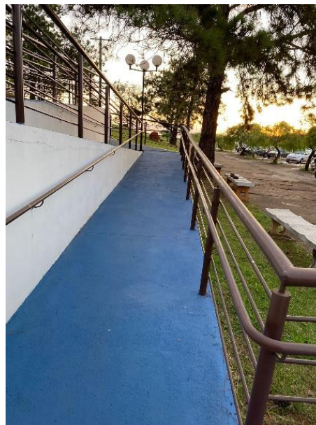
Figura 9: Rampa de acesso do Bloco 5 (2023)
