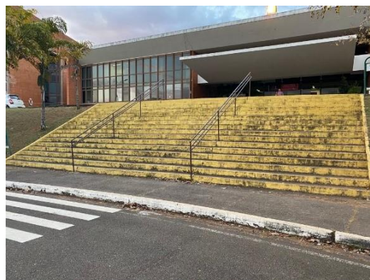
Figura 3: Escada de acesso do Bloco 1 (2023)
