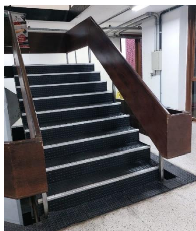
Figura 11: Escada de torre (2023)
